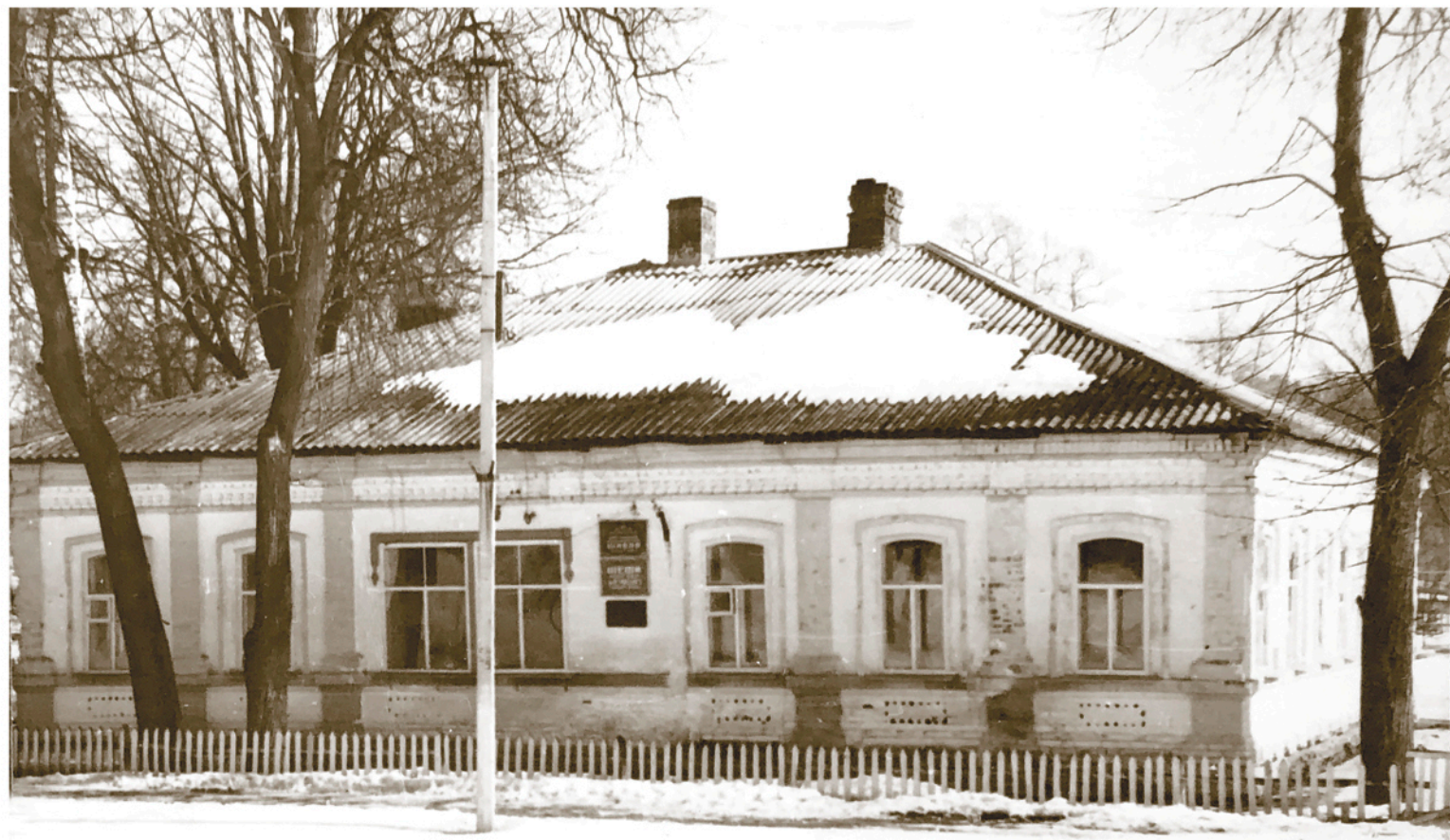
Будівля Могрицького земського початкового училища, зведена в 1883–1884 рр. Фото 1970-х рр. (особистий архів Левенця Олександра Лаврентійовича)
